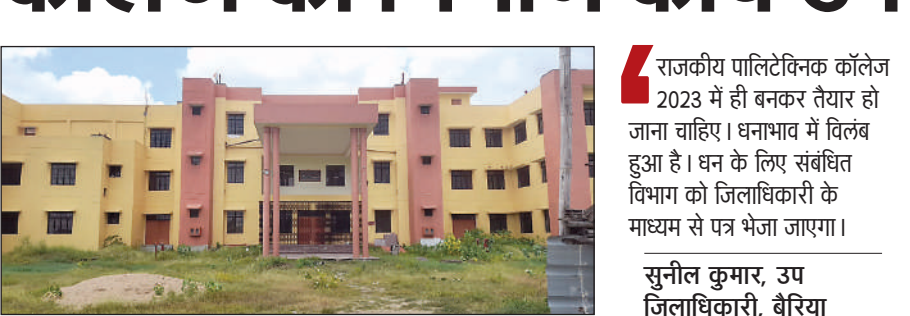
निर्माणाधीन राजकीय पॉलिटेक्निक
