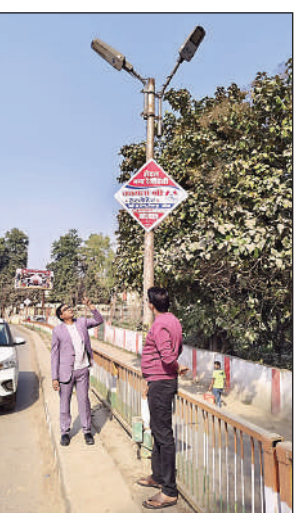
ओवरब्रिज पर स्टीट लाइट का निरीक्षण करते सीआरओ व अन्य।
