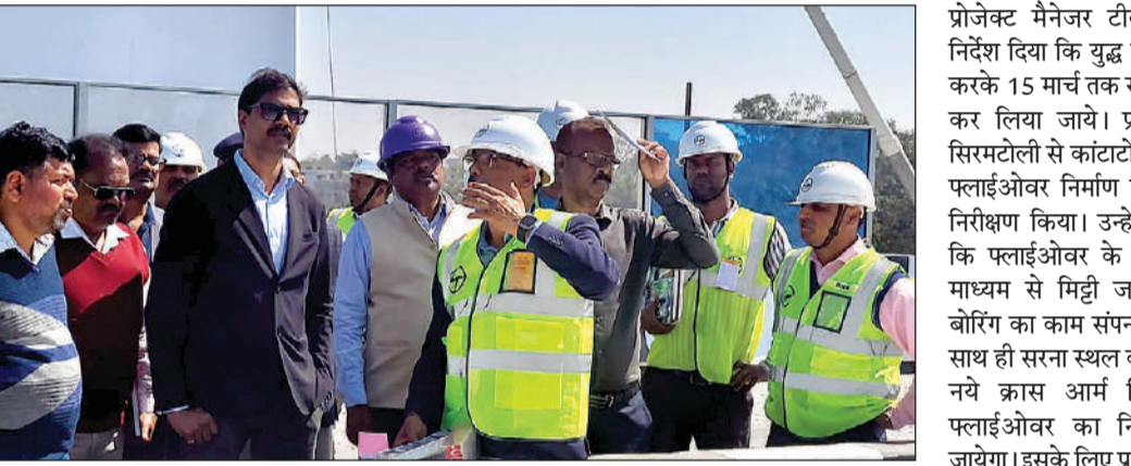
केबल स्टेबल ब्रिज एवं रेलवे लाईन के किनारे से निर्माण कार्य को बारीकी से देखा
